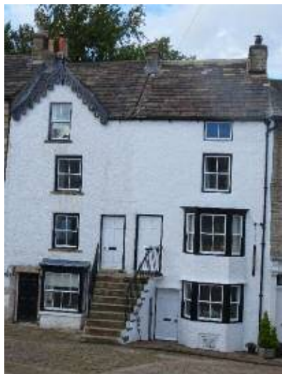
Extramural stairs to original front doors in Alston Grisiau allanol ar gyfer drysau ffrynt gwreiddiol yn Alston
