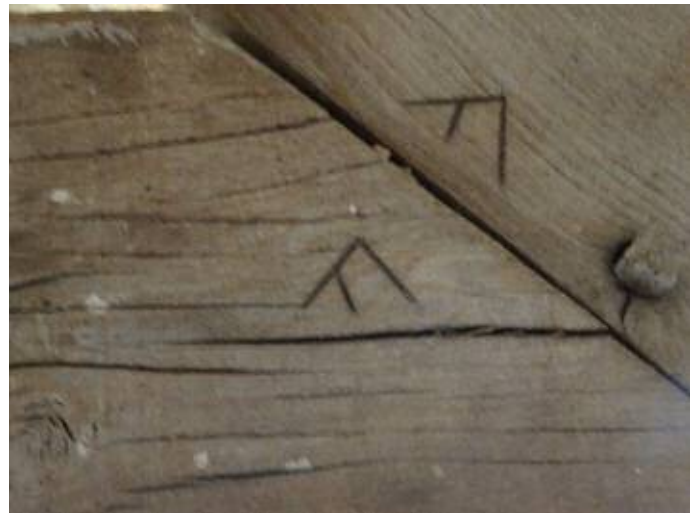
Carpenters' marks/Marciau gosod saer ar goed to yn, Llansilin
