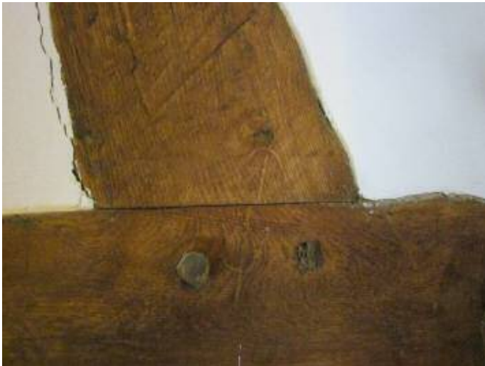
Marciau'r seiri coed yn nhrawstiau to, Sir Ddinbych Carpenters' marks in roof timbers, Denbs
